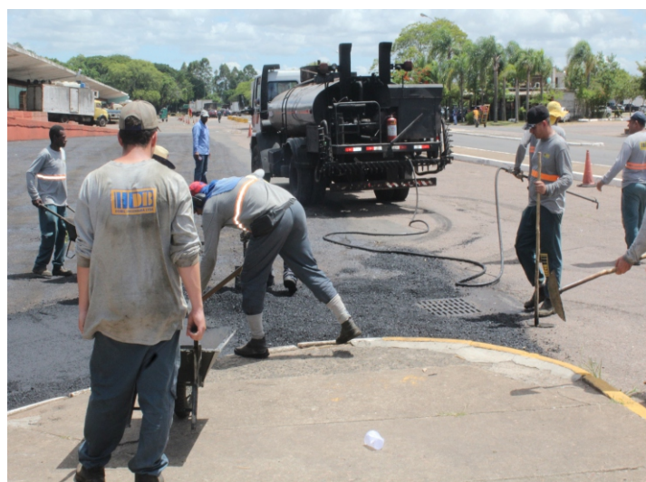
Pavimentação nas vias laterais ao Pavilhão dos Produtores recebeu novas camadas de asfalto em dezembro
