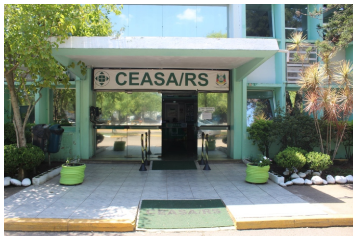
Quadro de servidores de carreira está aquém das necessidades
