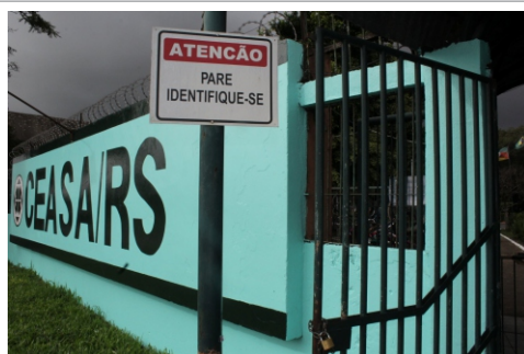
Pintura de muros, placas e logomarca
