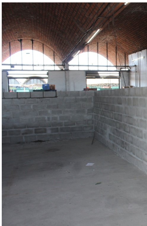
Servidores da equipe de Manutenção trabalham para finalizar a construção das paredes de quatro boxes dentro do amplo espaço
