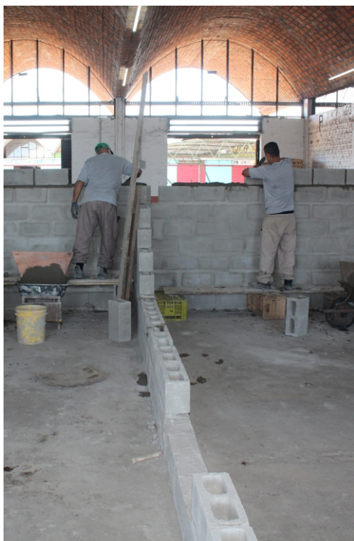
Servidores da equipe de Manutenção trabalham para finalizar a construção das paredes de quatro boxes dentro do amplo espaço
