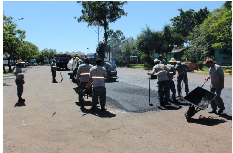
Empresa conta com vários operários na execução das tarefas que vão da varrição e limpeza da pista à aplicação de piche e de camadas de asfalto
