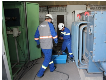
Equipamentos serão substituídos
