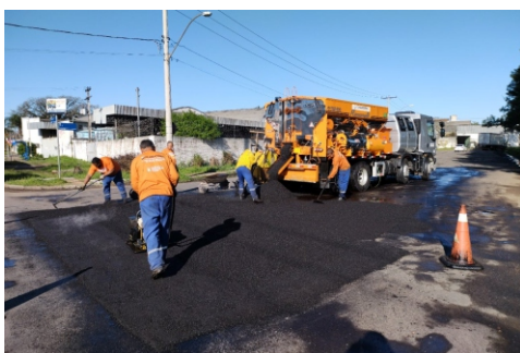
Recapeamento concluído em setembro
