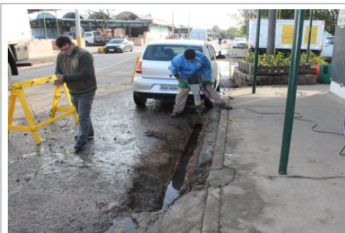
Substituição da rede de esgoto pluvial
