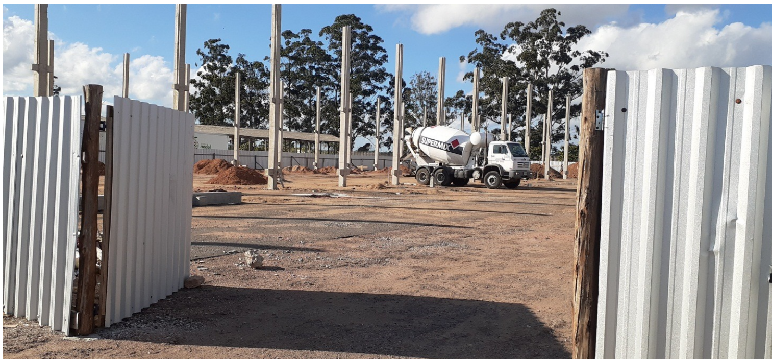
Segundo o diretor da DRT Logística, Denis Guerra Fabris, projeto de expansão prevê a instalação de plataformas e estruturas pré-moldadas
