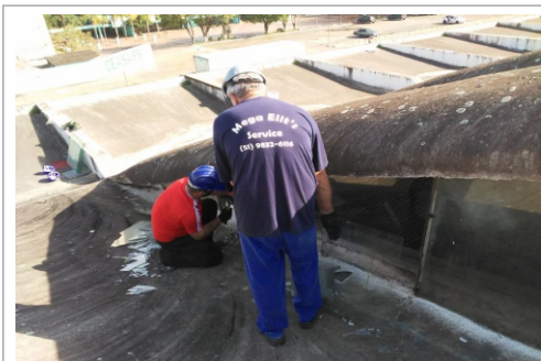
Vidros foram recolocados no telhado do GNP
