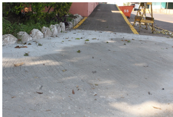
Piso nivelado facilita entrada e saída de carregadores
