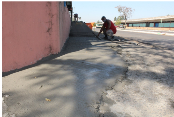
Rampas de acesso às plataformas receberam concreto
