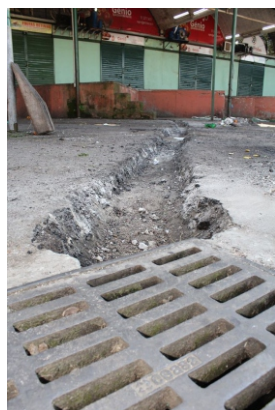
Canalização da rede pluvial no D2 resolverá o problema do acúmulo de água
