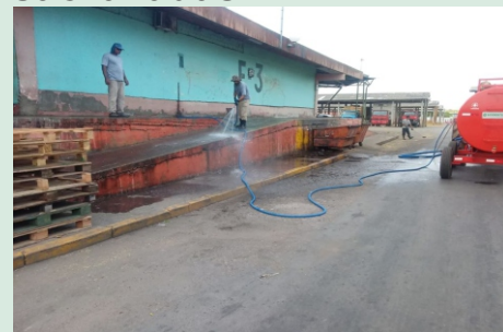
Limpeza em rampas, portas e paredes
