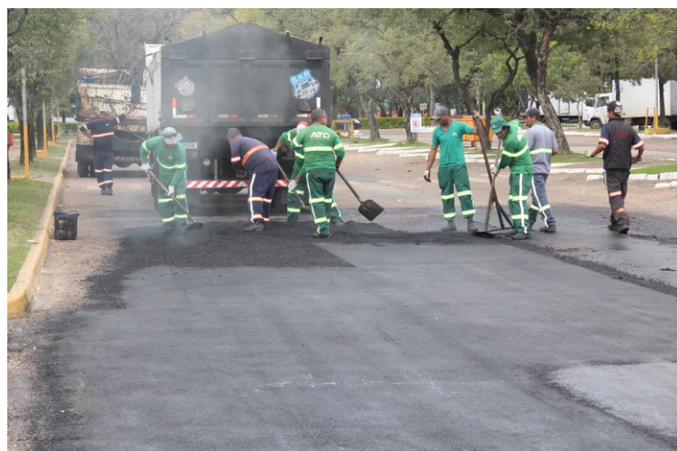
Camada asfáltica contemplará mais de 11 mil metros quadrados de pavimento
